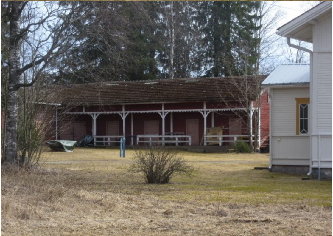
Yllä olevat kuvat Onnelan päärakennuksesta ja pihasta keväällä 2020.
